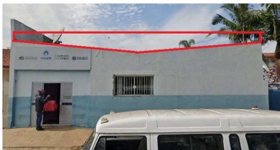
Figura 1: Fachada do prédio
