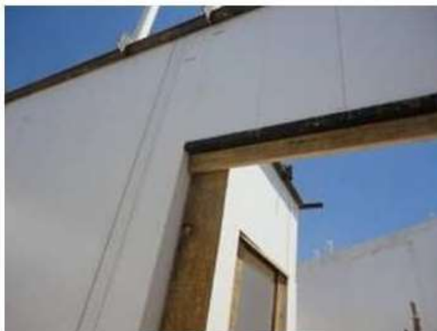
FIGURA 13 – Escoramento de aberturas de portas para concretagem
