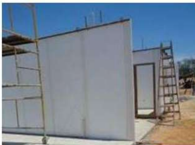
FIGURA 11 – Painéis de PVC posicionados e escorados
