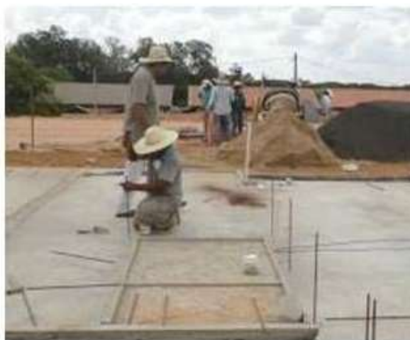
FIGURA 08 – Elemento de fundação com planicidade adequada
