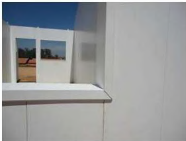
FIGURA 15 – Abertura das janelas com acabamentos em PVC
