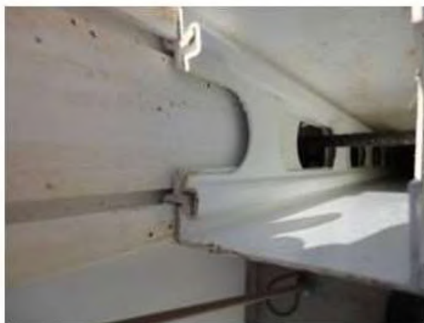
FIGURA 12 – Ferragem posicionada na região da contra-verga
