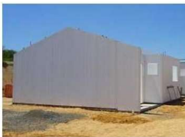
FIGURA 14 – Painéis de PVC concretados
