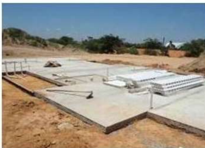
FIGURA 08 – Elemento de fundação com planicidade adequada
