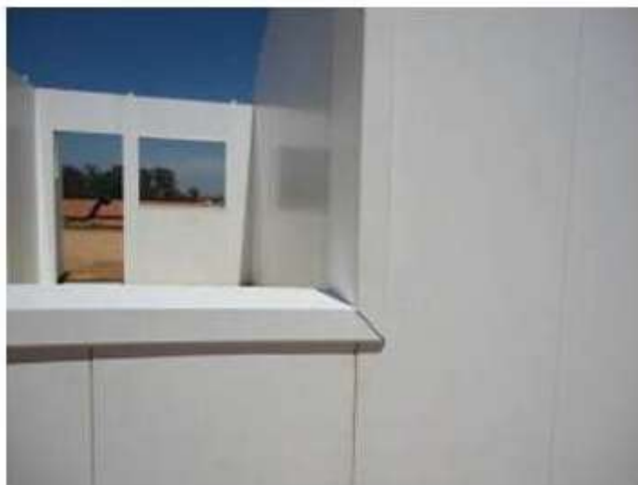
FIGURA 15 – Abertura das janelas com acabamentos em PVC
