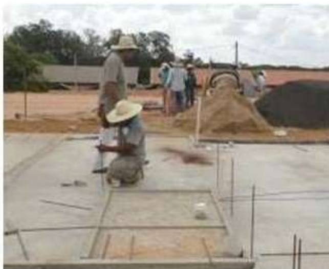
FIGURA 08 – Elemento de fundação com planicidade adequada
