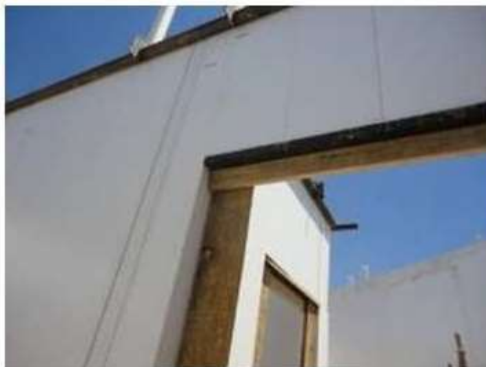
FIGURA 13 – Escoramento de aberturas de portas para concretagem
