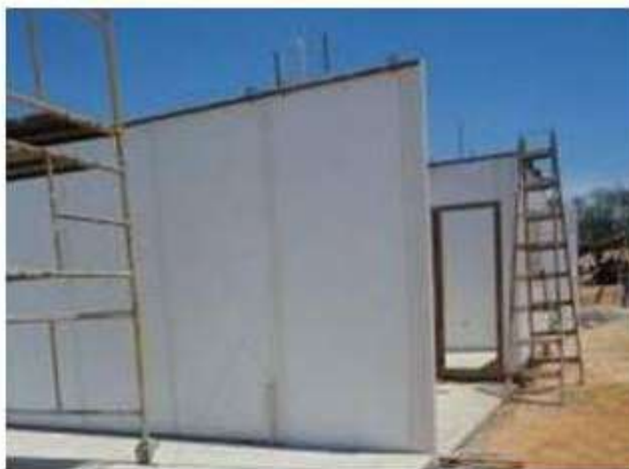
FIGURA 11 – Painéis de PVC posicionados e escorados
