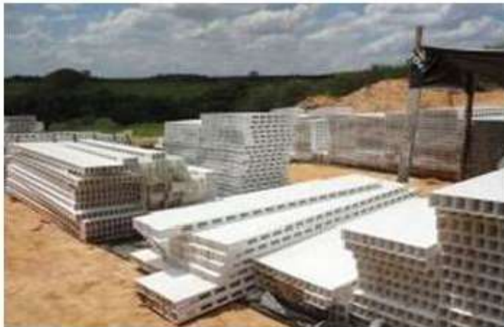
FIGURA 10 – Painéis de PVC pré-moldados na fábrica
