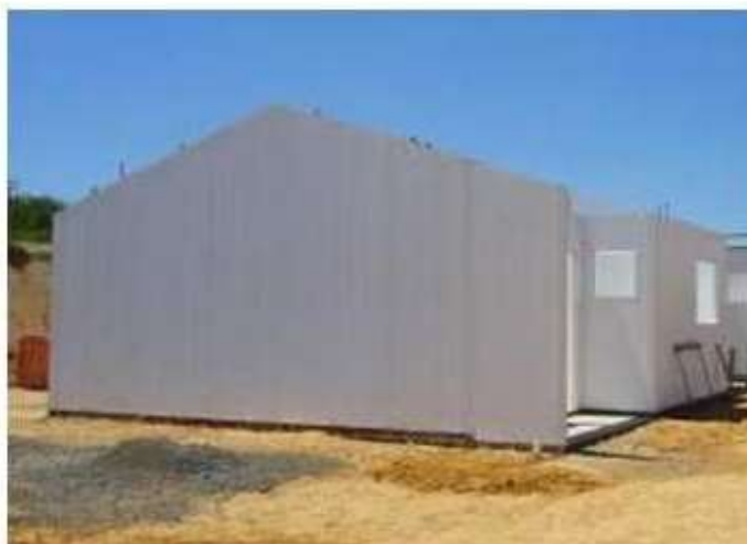
FIGURA 14 – Painéis de PVC concretados
