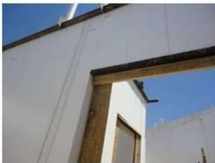
FIGURA 13 – Escoramento de aberturas de portas para concretagem
