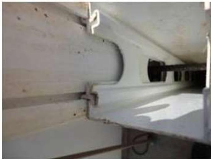
FIGURA 12 – Ferragem posicionada na região da contra-verga
