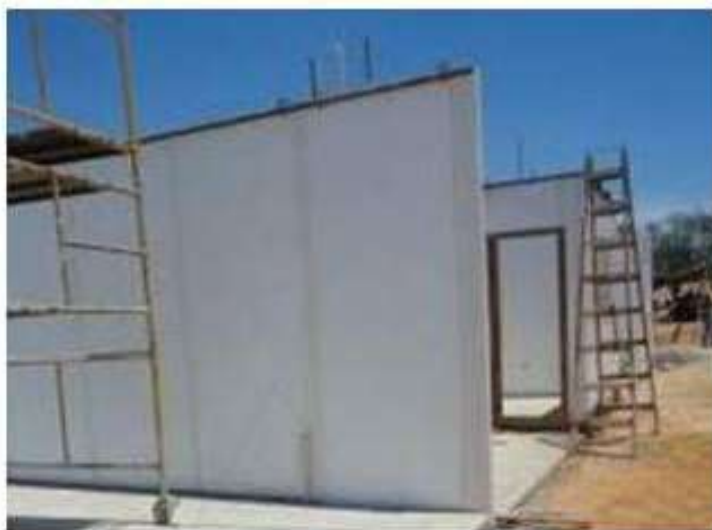
FIGURA 11 – Painéis de PVC posicionados e escorados
