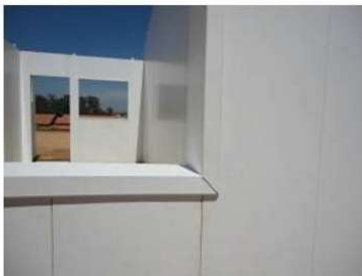
FIGURA 15 – Abertura das janelas com acabamentos em PVC
