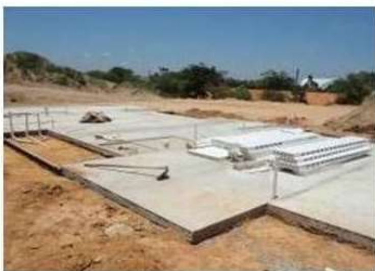
FIGURA 08 – Elemento de fundação com planicidade adequada
