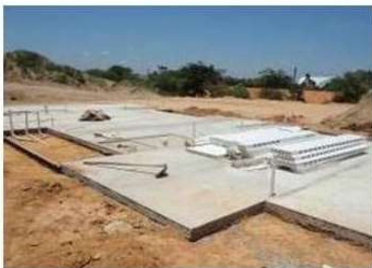
FIGURA 08 – Elemento de fundação com planicidade adequada
