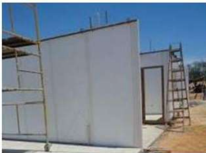
FIGURA 11 – Painéis de PVC posicionados e escorados
