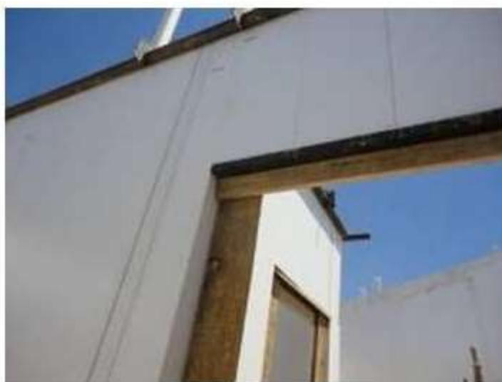
FIGURA 13 – Escoramento de aberturas de portas para concretagem
