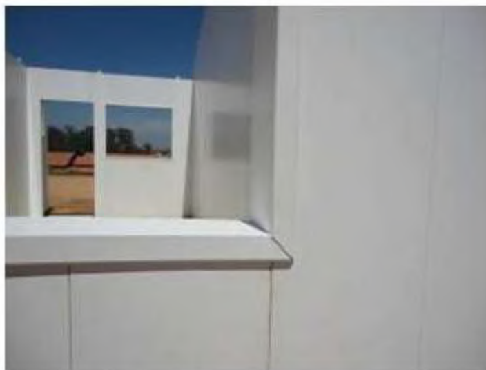
FIGURA 15 – Abertura das janelas com acabamentos em PVC
