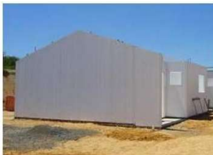
FIGURA 14 – Painéis de PVC concretados
