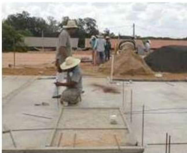
FIGURA 08 – Elemento de fundação com planicidade adequada
