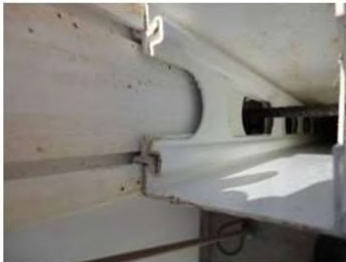
FIGURA 12 – Ferragem posicionada na região da contra-verga
