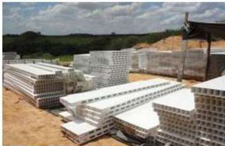
FIGURA 10 – Painéis de PVC pré-moldados na fábrica
