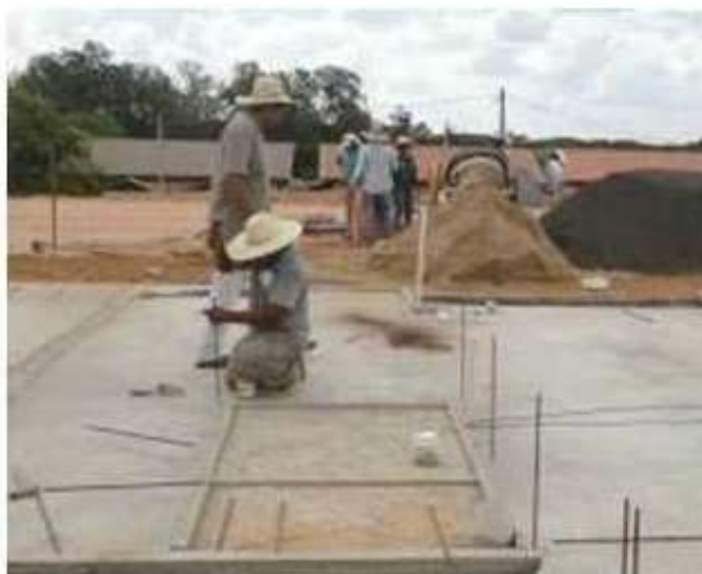
FIGURA 08 – Elemento de fundação com planicidade adequada
