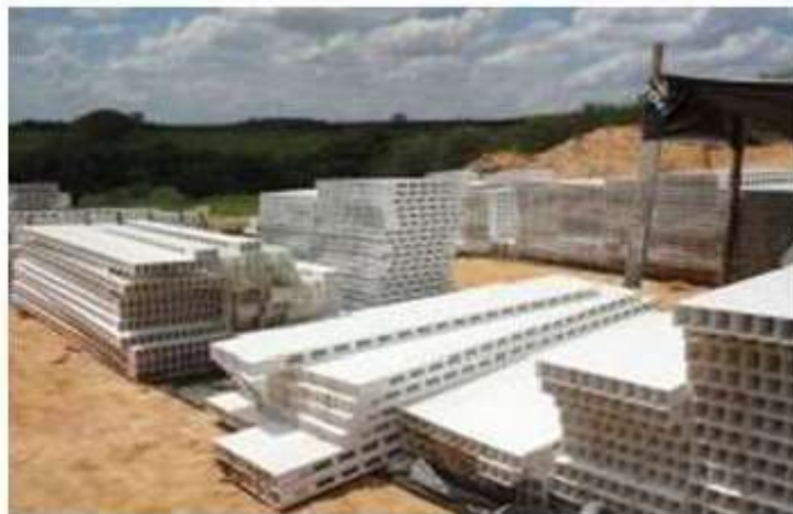
FIGURA 10 – Painéis de PVC pré-moldados na fábrica
