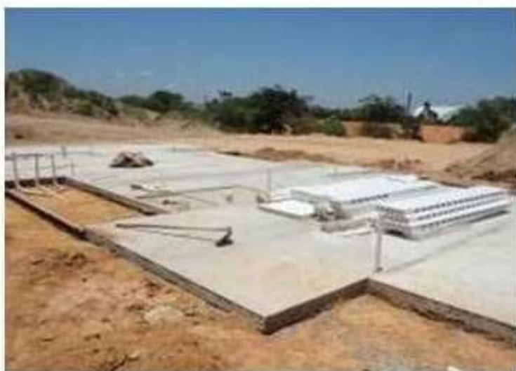
FIGURA 08 – Elemento de fundação com planicidade adequada
