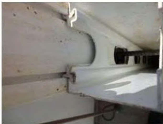
FIGURA 12 – Ferragem posicionada na região da contra-verga
