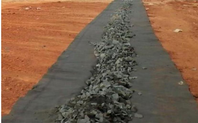
*Figura 3: Foto demonstrativo: Sistema de drenagem de chorume já devidamente preenchido com a brita 04.*
