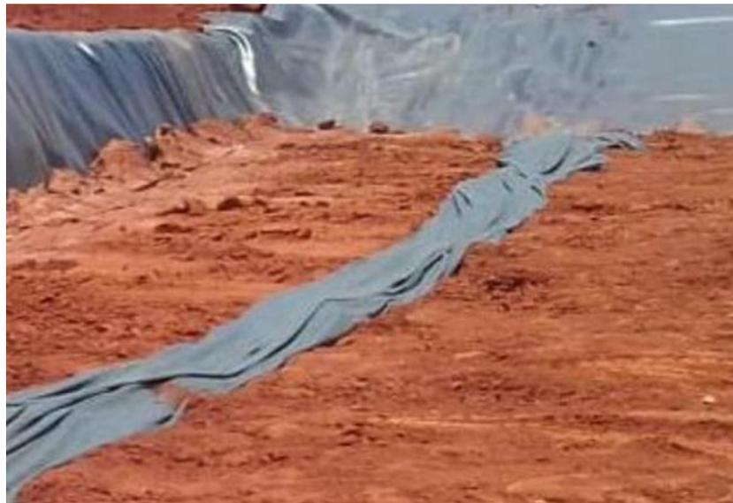
*Figura 4: Foto demonstrativo: Dreno de chorume já devidamente concluído e protegido pela manta de geotêxtil não tecido.*
