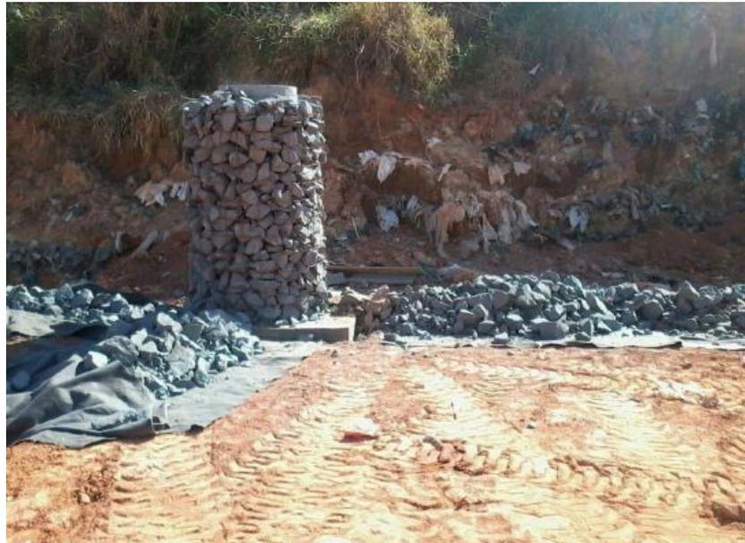
*Figura 9: Foto demonstrativo: Sistema de biogás já devidamente pronto sobre a caixa de passagem do sistema de drenagem de chorume.*
