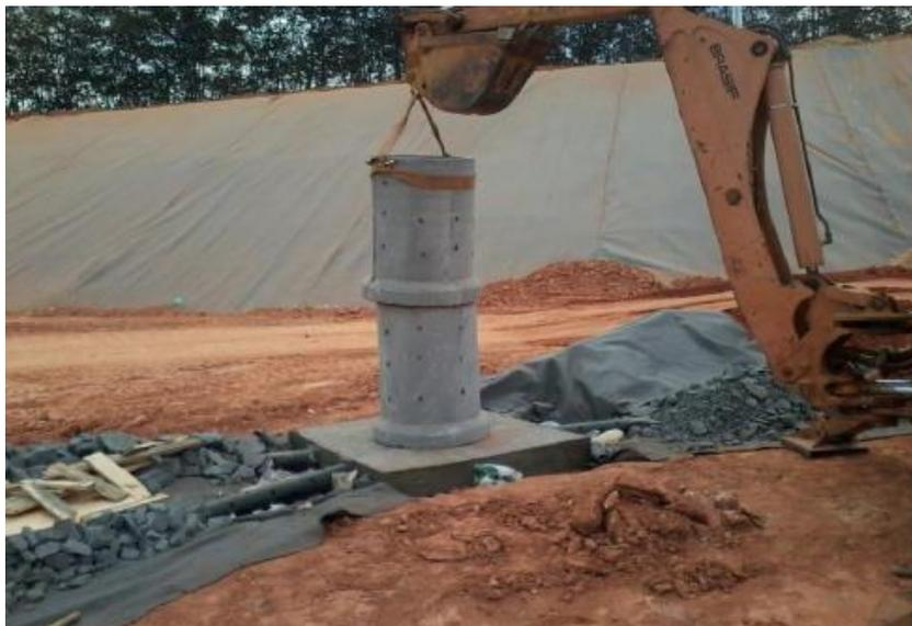
*Figura 7: Foto demonstrativo: Tubos de concreto perfurados sendo colocado sobre a caixa de passagem.*
