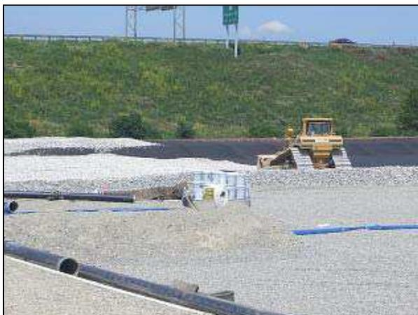
**Foto 26 – Nivelamento da Base da Célula**
