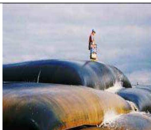
Foto 43 – Utilização de Vibrador de Superfície em Caso de Entupimento dos Bags
