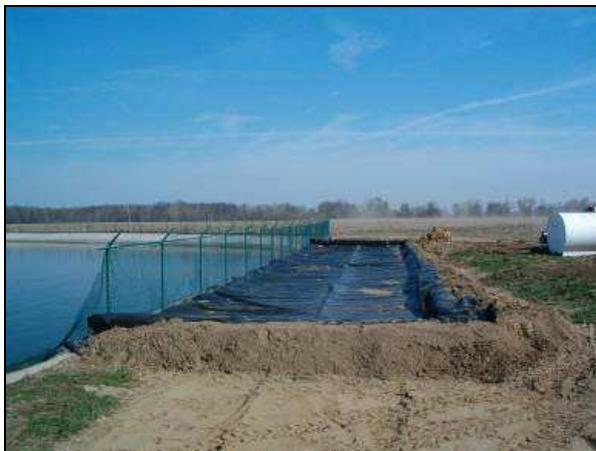
**Foto 28 – Detalhe da Barragem de Contenção Construída para Evitar que o Efluente Drenado não Percole no Terreno**
