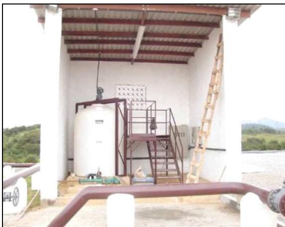
Foto 40 – Vista do Modelo de Abrigo Para Equipamentos de Dosagem de Polímero
