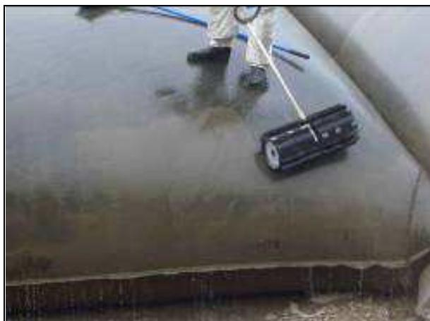
**Foto 44 – Manutenção - Limpeza dos Bags com Jateamento com Água Limpa**
