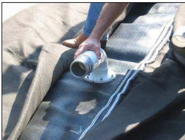
Foto 34 – Conexão para Tubo Flexível
