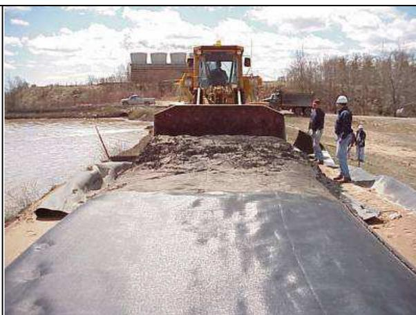
**Foto 45 – Remoção do Lodo Após o Término do Processo Através de Pá Carregadeira**
