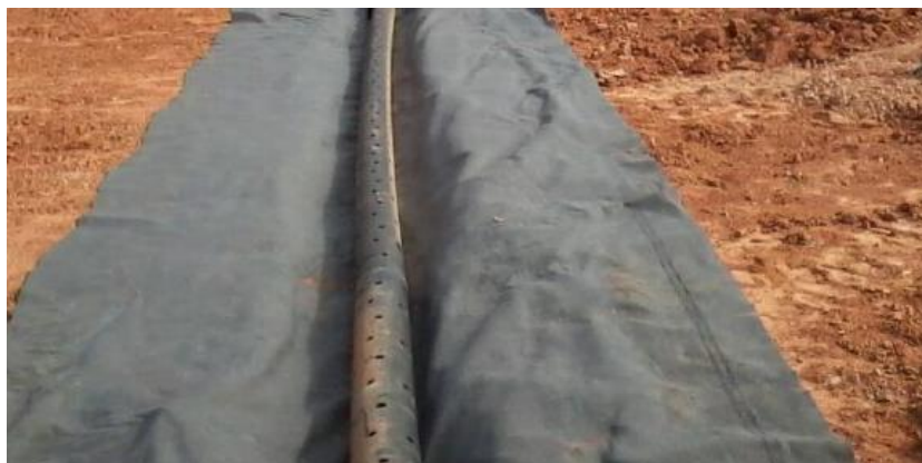
Figura 2 : Foto demonstrativo: Vala do sistema de drenagem de chorume, já aberta, envolta com a manta geotextil não tecido, e com o tubo de PEAD perfurado em seu interior.
