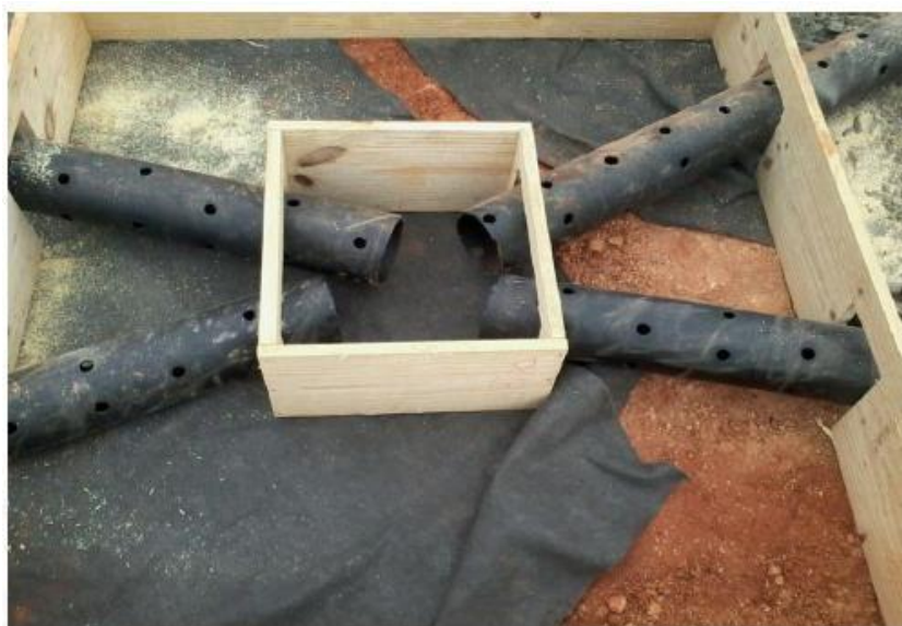
Figura 5: Foto demonstrativo: forma devidamente montada da caixa de passagem
