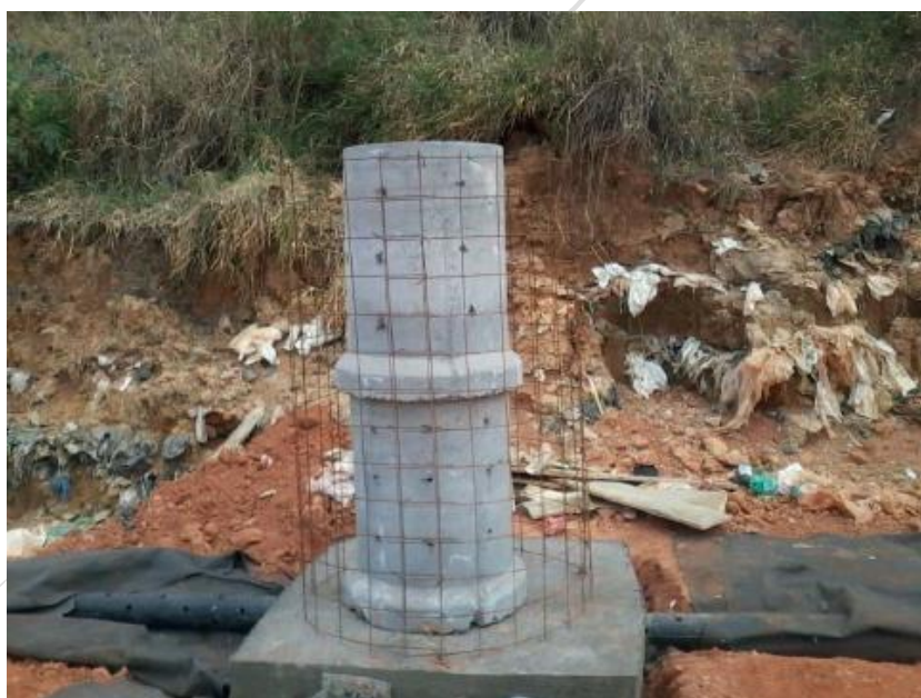
Figura 8: Foto demonstrativo: Tubos já devidamente envolvidos pela tela Telcon.
