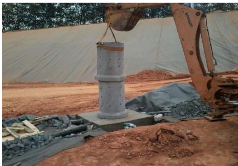
Figura 7: Foto demonstrativo: Tubos de concreto perfurados sendo colocado sobre a caixa de passagem.
