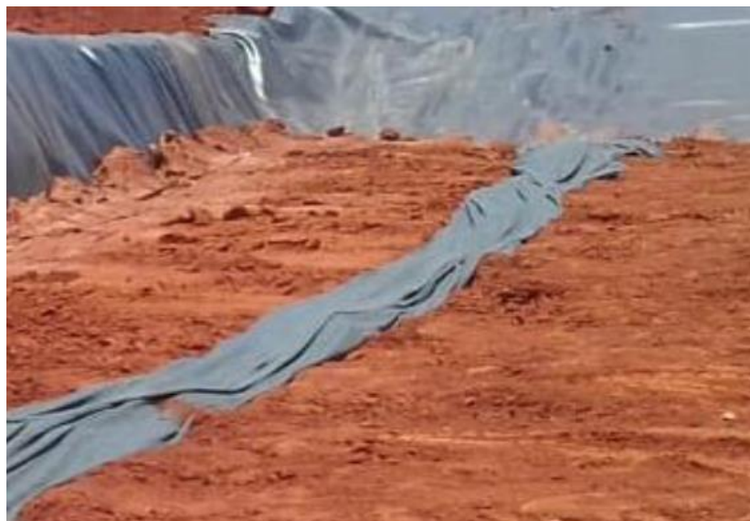
Figura 4: foto demonstrativo: Dreno de chorume já devidamente concluído e protegido pela manta de geotêxtil não tecido.
