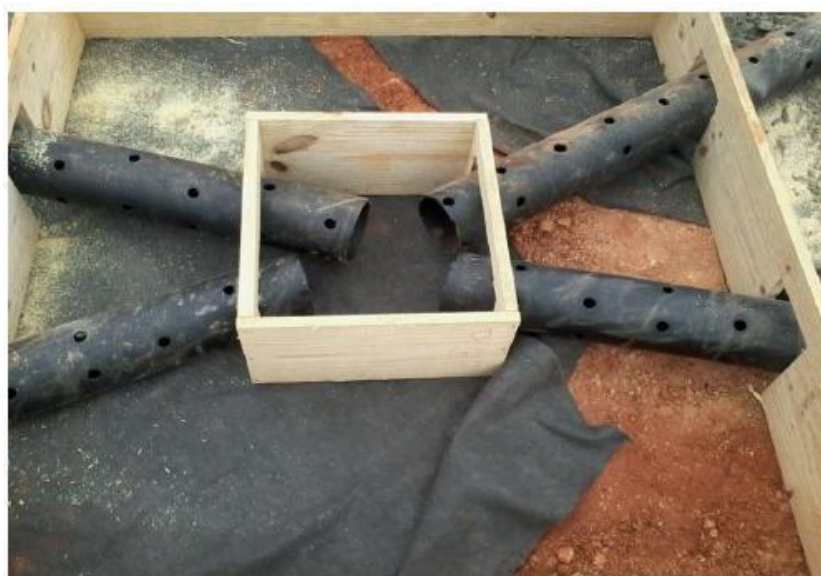
Figura 4: foto demonstrativo: Dreno de chorume já devidamente concluído e protegido pela manta de geotêxtil não tecido.
