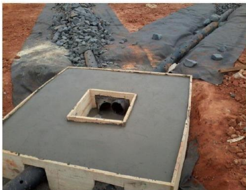
Figura 6: Foto demonstrativo: Caixa de passagem já devidamente concretada com fck30.
