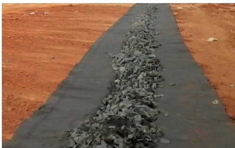
Figura 3: Foto demonstrativo: Sistema de drenagem de chorume já devidamente preenchido com a brita 04.
