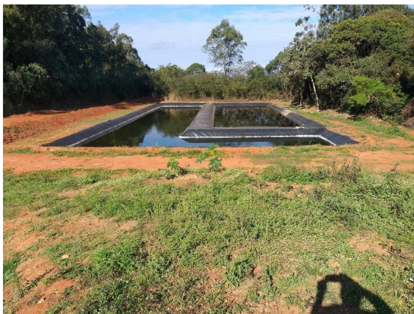
Figura 11: Lagoa de chorume do Aterro Sanitário de Capão Bonito, 2021.
