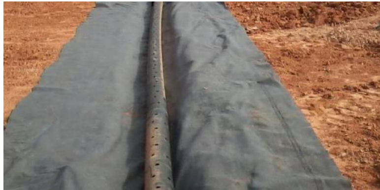
Figura 2: Foto demonstrativo: Vala do sistema de drenagem de chorume, já aberta, envolta com a manta geotextil não tecida, e com o tubo de PEAD perfurado em seu interior.
