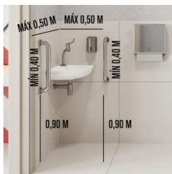
Figura 3: Medidas da instalação
